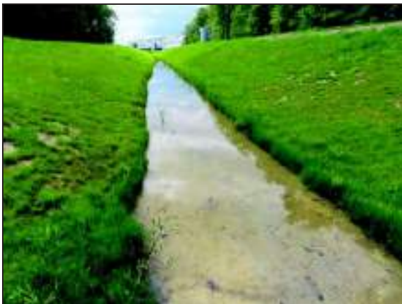
11- Noue d'eaux pluviales (juillet 2021)
