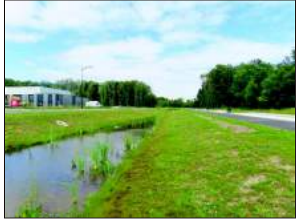
14- Noue d'eaux pluviales (juillet 2021)
