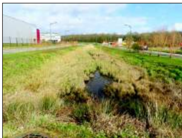
4-Noue d'eaux pluviales (mars 2021)
