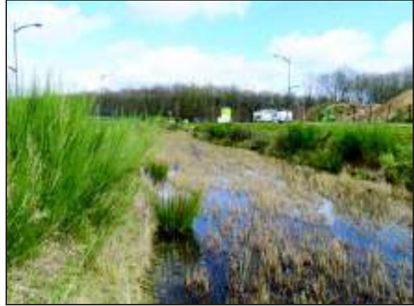
8- Noue d'eaux pluviales (mars 2021)
